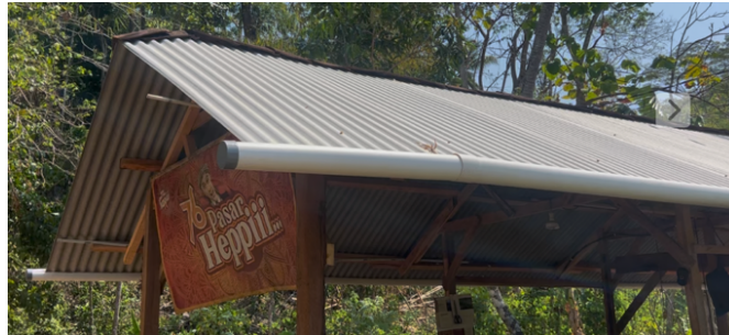
Gambar 2. Atap Bangunan yang Dimanfaatkan sebagai Area Tangkapan Air (sumber: pribadi)
